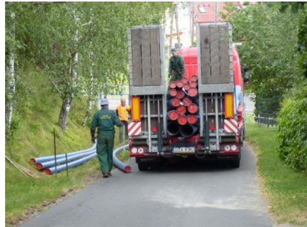
Ulica Górna. Początek robót.
