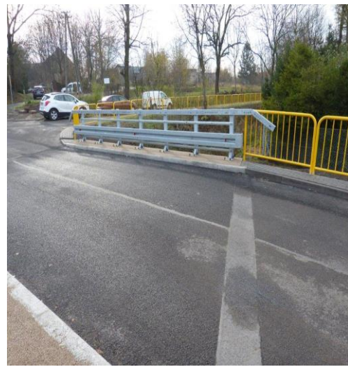
Przebudowa mostu drogowego ul. Henryka Sienkiewicza
