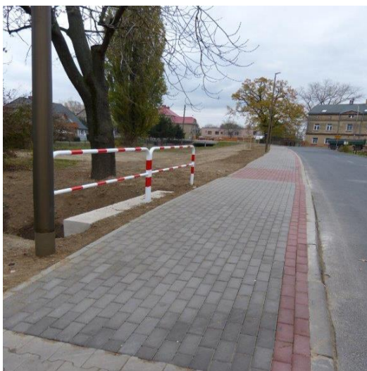
Budowa chodnika przy ul. Stawowej
